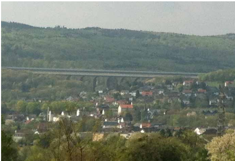
Blick auf die Theistalbrücke mit Theistal (Quelle: Eigenes Foto)
